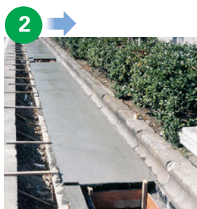
コンクリート打設
