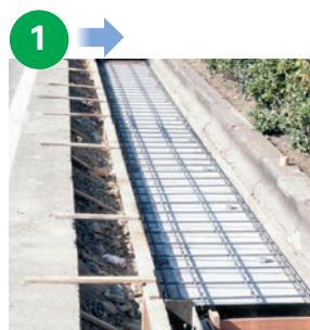
KCフォームの上に配筋した状態
