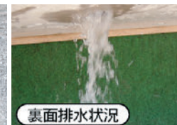
〔裏面排水状況〕
